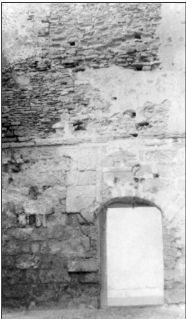
Imagen 12.- La puerta del frente este en 1956. Se observa el alzado superior sin enlucir
