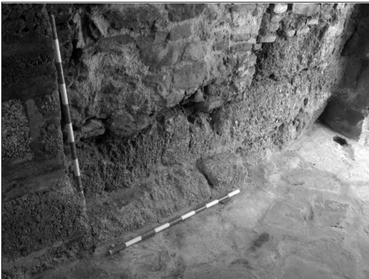
Imagen 7.- Resaltado lateral y quialera inferior, recolocada en su posición original
