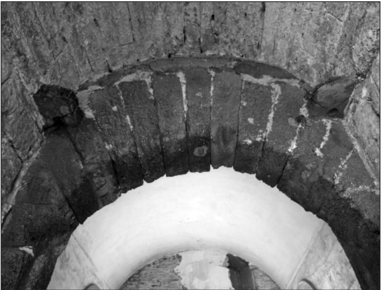
Imagen 6.- Quicaleras superiores en arco interno
