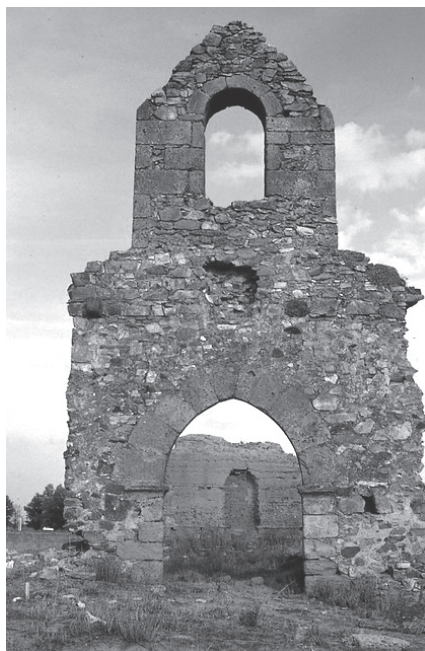
2. Ruinas de la ermita de San Lázaro hacia 1992 (Se aprecia perfectamente el hueco sobre el arco, donde estuvieron las armas de la familia Charro) [Foto Rafael González]
