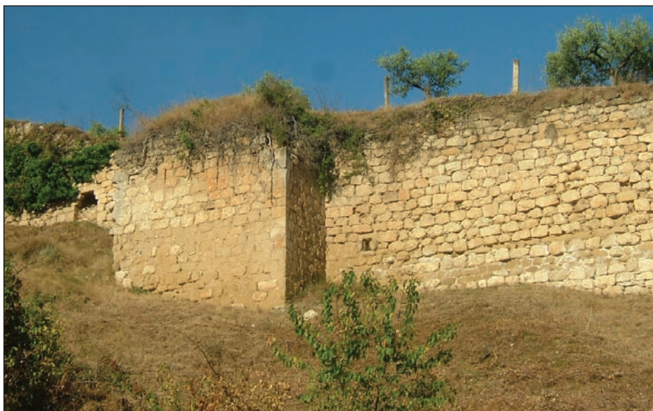
Foto 2. Estado actual de la muralla de la Judería
