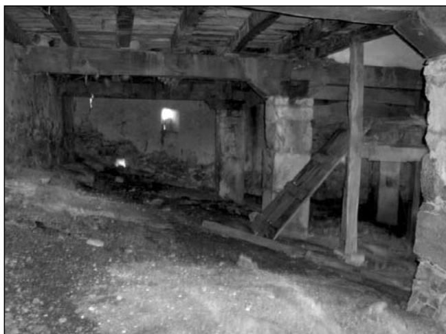
Cuadra con desnivel en roca viva
