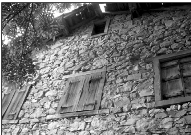
Detalle de la fachada
