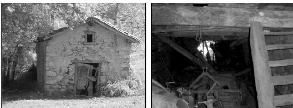
Aspecto de la fachada y del interior desde la escalera al “sabaí”
