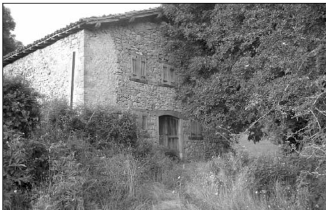
Vista general de la fachada
