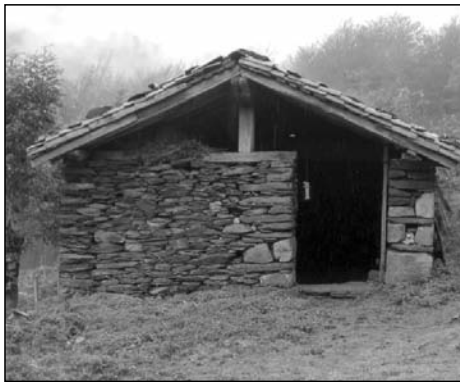
Borda en la zona de Donamaría, de una sola planta, destinada a guardar ovejas (ardiborda). Este tipo no se da en el valle de Erro y en Auritz/Burguete
