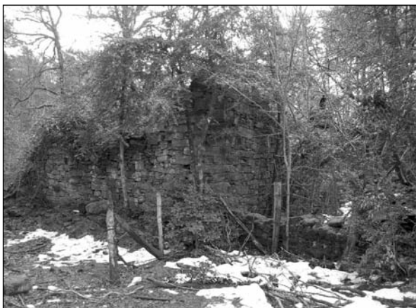
En 1929 estaba en uso. En la foto de la derecha de 1956-1957 se aprecia el abandono de la edificación y su invasión por el arbolado y la maleza, que es completa en 2006
