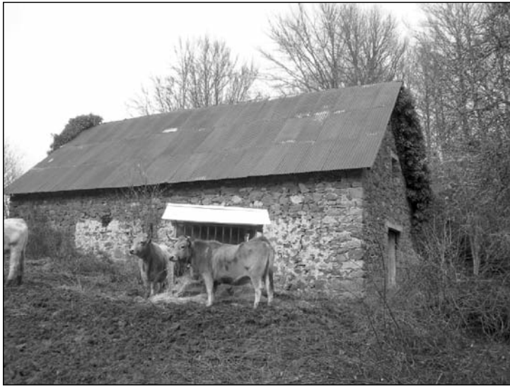
Borda en Garaioa (valle Aezkoa). Las plantas de estas construcciones, respecto a las construcciones de influencia atlántica, son más cuadradas, comparativamente más anchas y bajas en altura. La cubierta presenta mayor inclinación y teja plana en general
