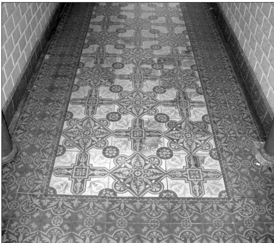
Solado hidráulico de magnífica policromía y con la típica disposición a modo de alfombra en un portal de la calle Mayor de Pamplona (Fotografía del autor)
