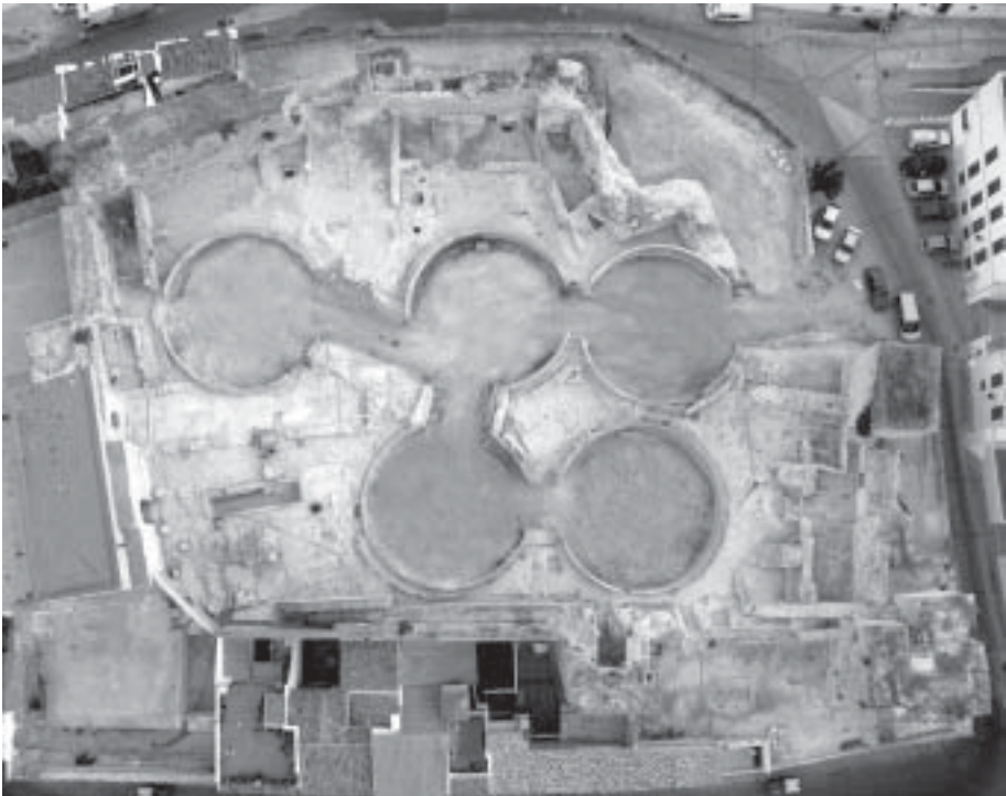
Vista cenital del castillo de Baena con los antiguos depósitos de agua de la localidad situados en el patio de armas
