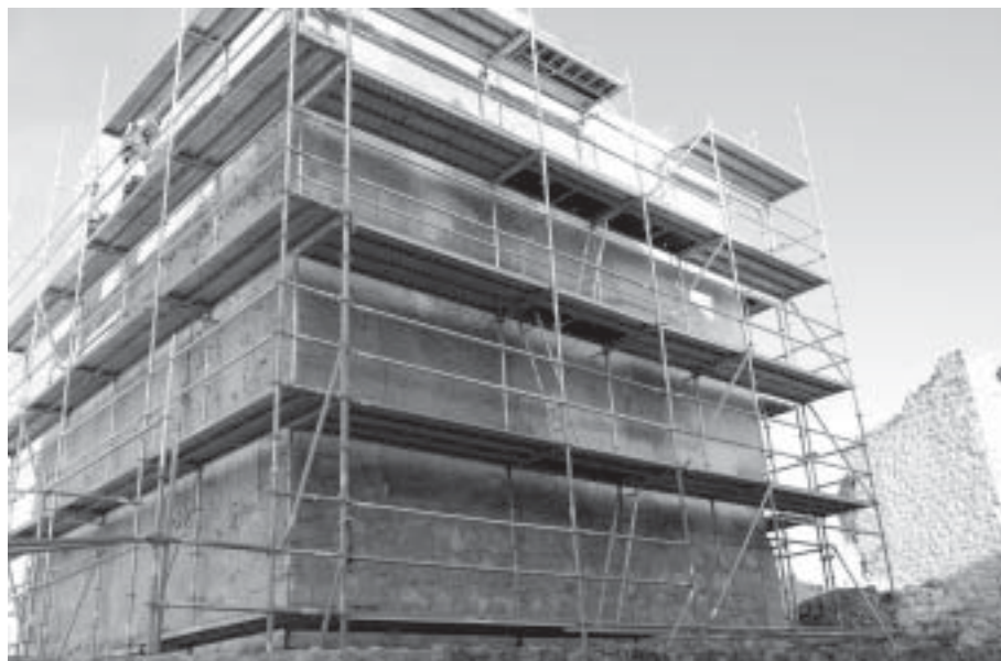
Panorámica de la Torre de los Secretos rodeada de andamios
