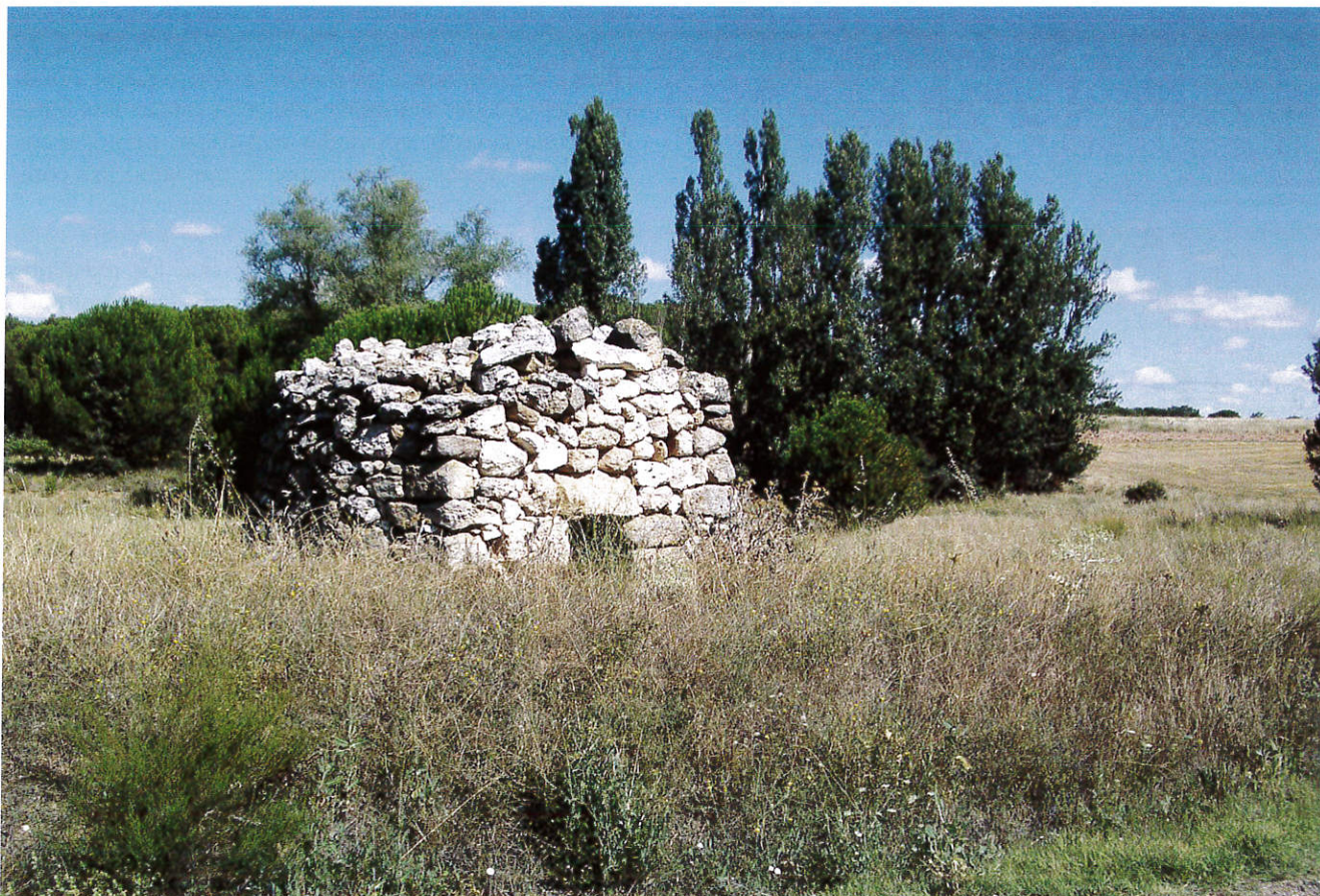
Figura 5. Chozo en el término de Fuentelisendo con el frente plano, como las navetas menorquinas
