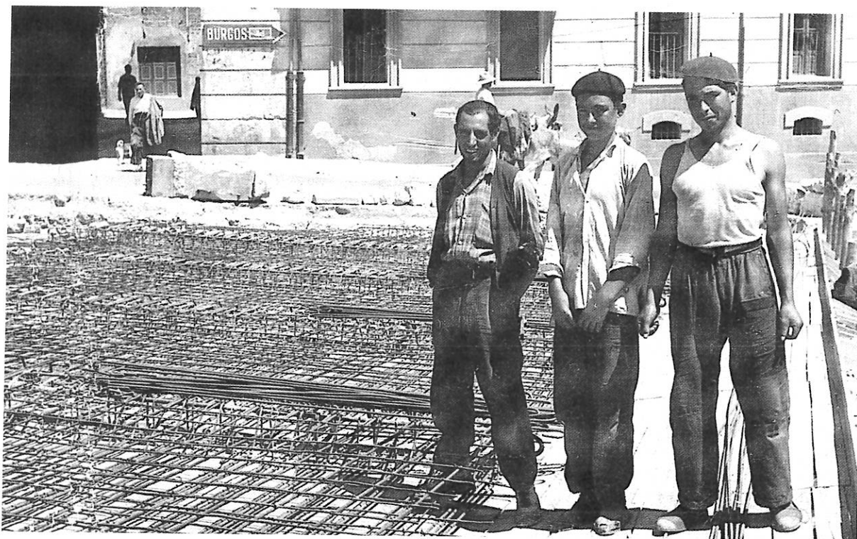
Fig. 25. Trabajadores realizando las faenas del ensanche del puente de Aranda en la Carretera Nacional I. Cartelera nº 247.
