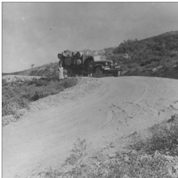
FIG. 4. Camión y vía de saca.
