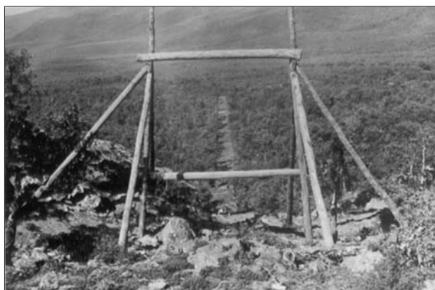
FIG. 5. Cable aéreo instalado en el monte Bouhassen.
