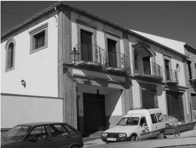
Casa en el solar del antiguo cortijo.
