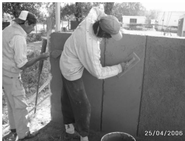
**Figura 13:** Revoques bicapa sobre tapia
