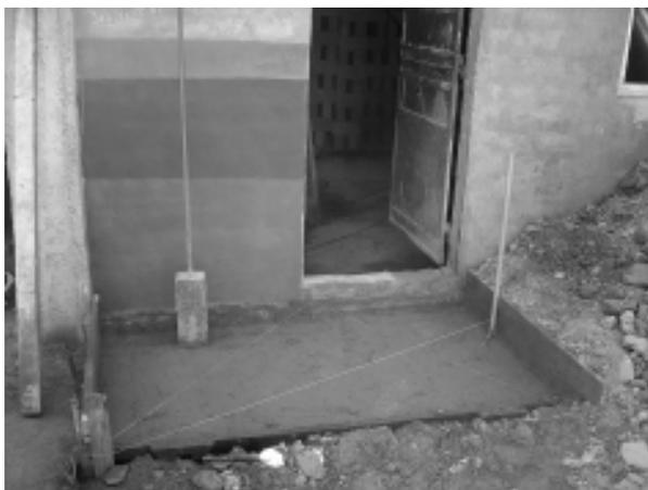
**Figura 11:** Contrapiso de suelo estabilizado compactado
