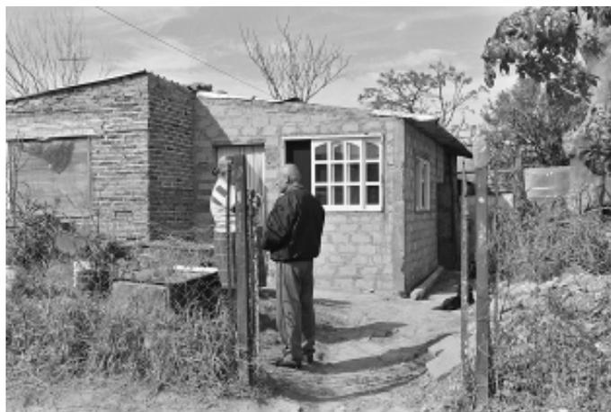
**Figura 5:** Paredes exteriores de ladrillo y bloque sin revocos
