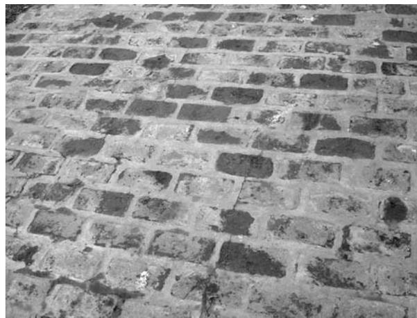
**Figura 4:** Piso de ladrillos de plano
