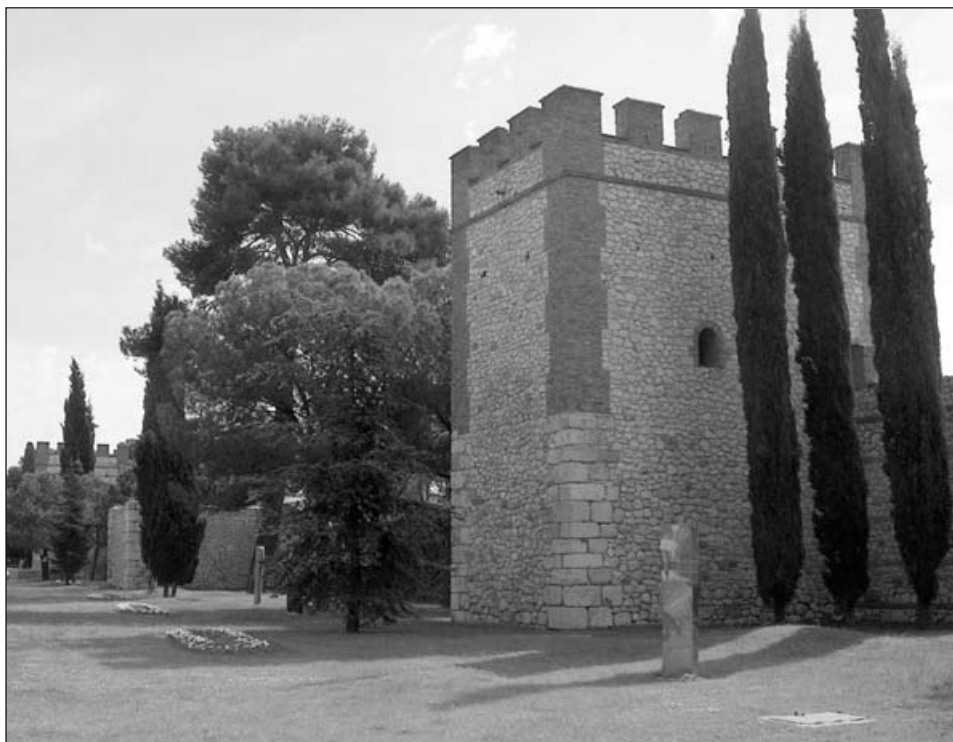
FIG. 8.—Vista actual de la muralla de Alcalá de Henares, desde la Vía Complutense. Fotografía de Josué Llull.
