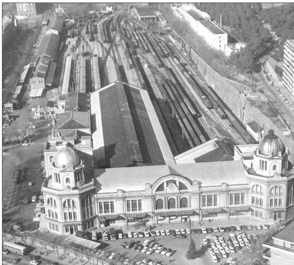
FIGURA 7.—Aspecto de la zona de la estación de Príncipe Pío con el segundo de sus edificios destinado a salida de viajeros, oficinas del paseo del Rey y almacenes situados en el paseo de la Florida.
