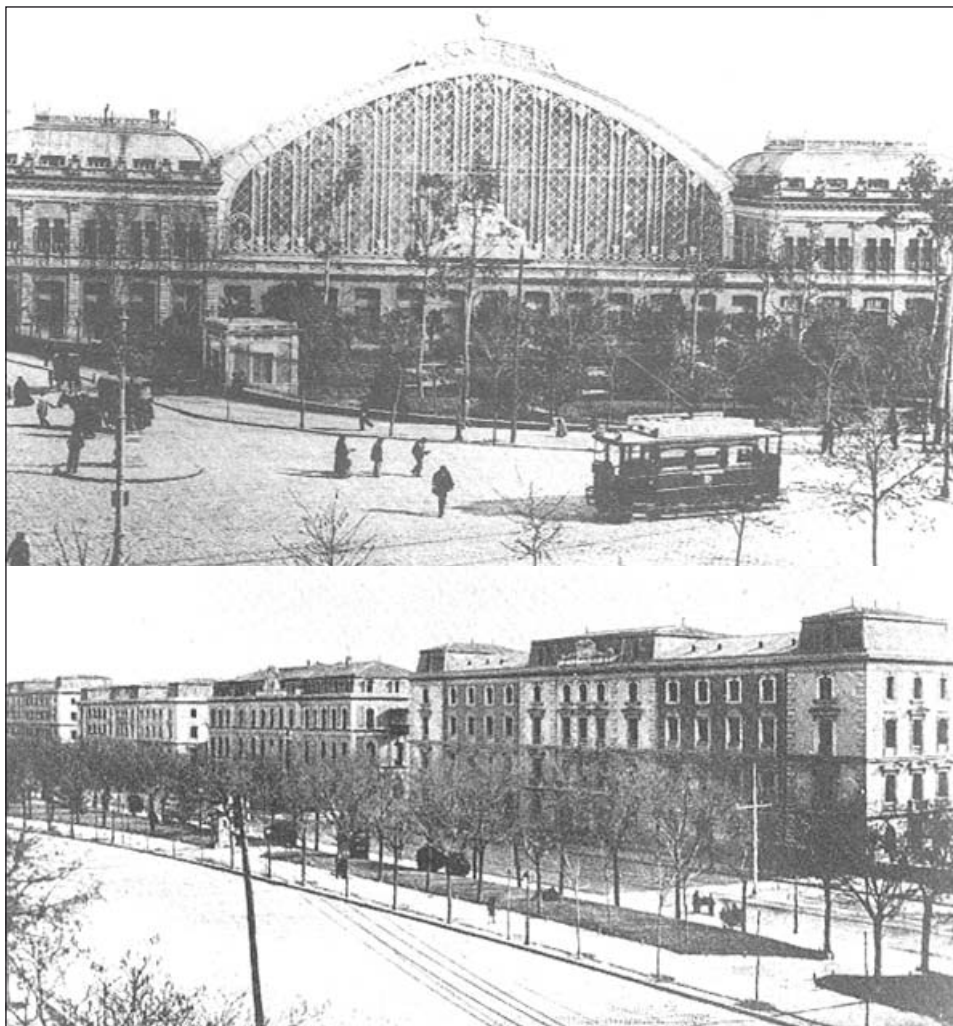
FIGURAS 4 y 5.—Aspecto de la fachada de la estación de Atocha construida por A. Palacios en 1888, que ha perdurado hasta la actualidad y edificios de oficinas, incluido en que fuera antigua fachada de la estación, de 1863, que dan comienzo a la avenida Ciudad de Barcelona (Archivo de RENFE).
