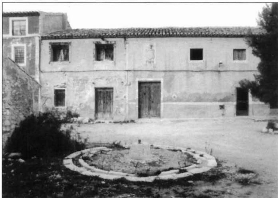
LÁMINA 7. Hacienda de Santa Inés. En primer término estructura circular del molino de aceitunas. Al fondo parte del sector rústico de la edificación.
