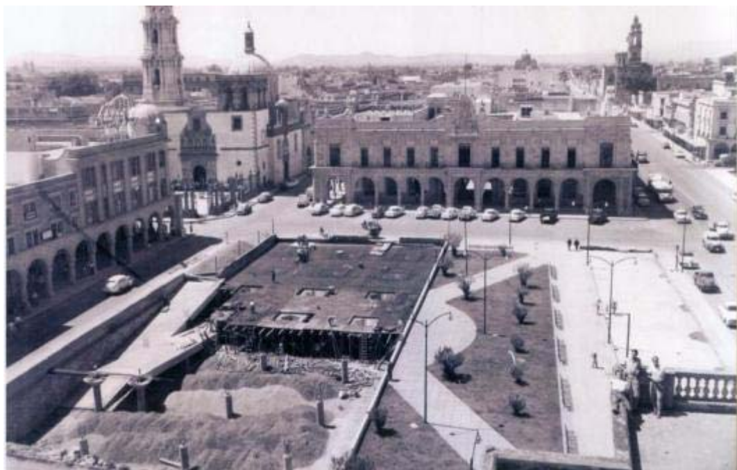
Fotografía 32. El primer aparcamiento subterráneo se va cubriendo
