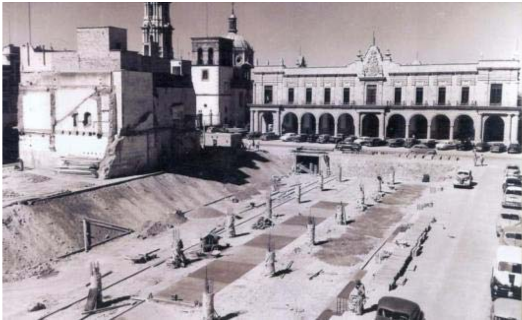
Fotografía 31. Demoliciones y vaciado del primer aparcamiento subterráneo delante del edificio Municipal
