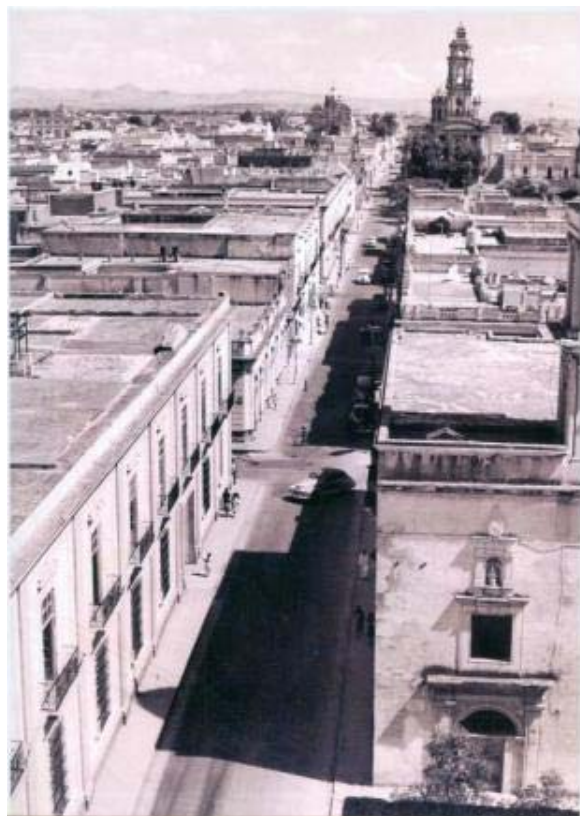
Fotografía 26. Perspectiva de la calle Alcalde antes de la reforma
