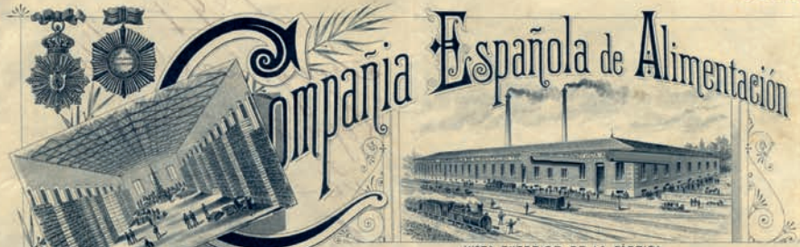
VISTA EXTERIOR DE LA FÁBRICA TOMADA DE LA VÍA DEL FERRO-CARRIL
