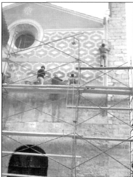
Fig. 34 i 35. L'any 1990 també es va restaurar la façana lateral amb la reproducció dels mateixos esgrafiats existents
