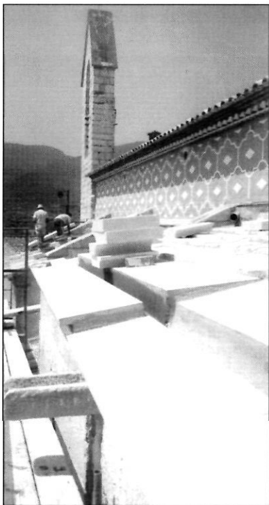
Fig. 30. Reconstrucció amb el nou enllosat de les cobertes de les capelles
