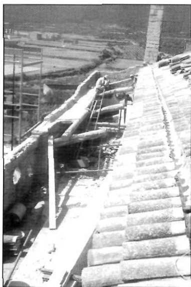
Fig. 25. Detall dels esgrafiats i enllosat de la coberta de les dues capelles gòtiques, descoberts abans de les obres
