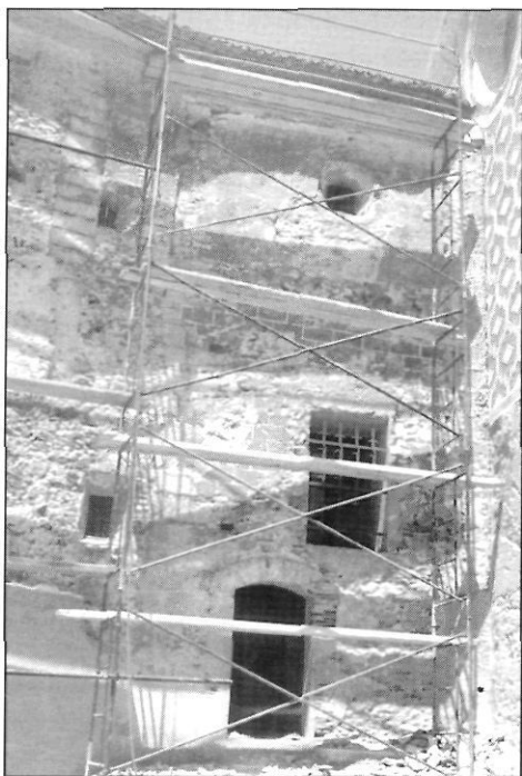
Fig. 40 i 41. Durant les obres es van trobar elements de diferents èpoques que es van deixar al descobert i es van reproduir els esgrafiats originals
