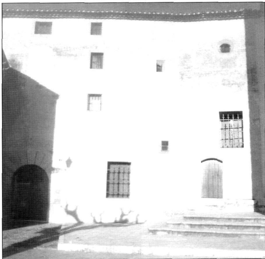
Fig. 39. Façana d'entrada al convent abans de començar les obres de l'any 1995
