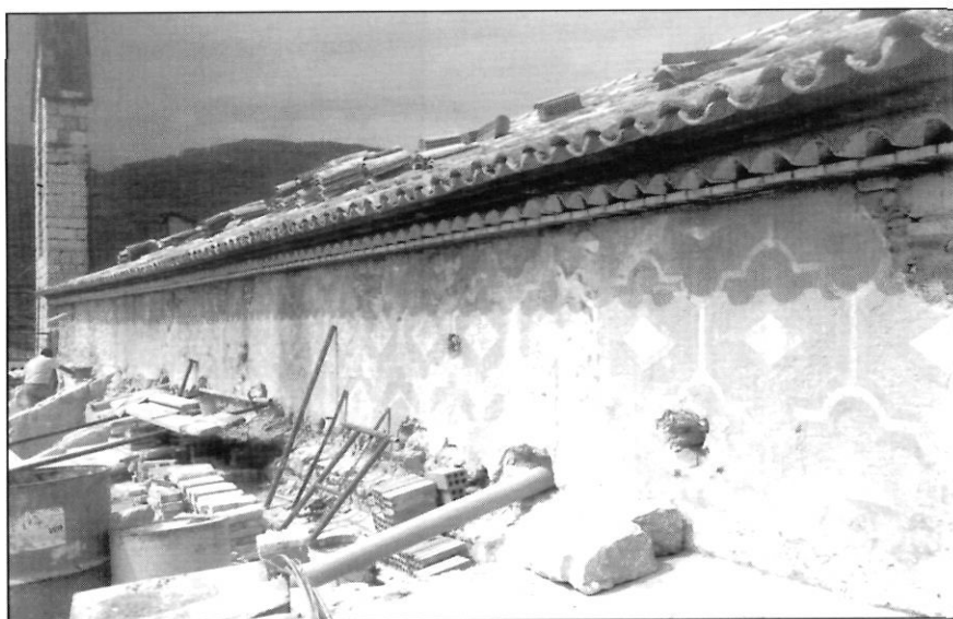
Fig. 28. Part superior de la façana principal amb el ràfec ja restaurat, amb els esgrafiats originals al descobert
