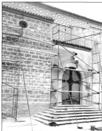
Fig. 31, 32 i 33. Durant la segona fase es va restaurar el tram de la porta principal, amb uns nous esgrafiats, i la capella renaixentista
