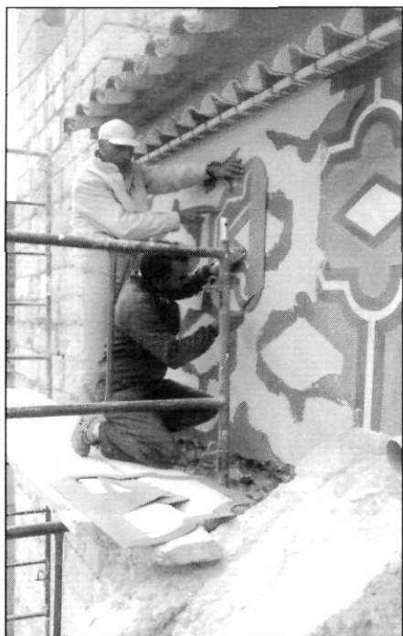
Fig. 29. Fent els esgrafiats, reproduïts dels originals
