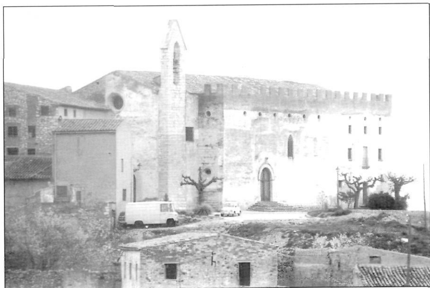
Fig. 23. Façana de l'església abans de començar les obres de l'any 1988
