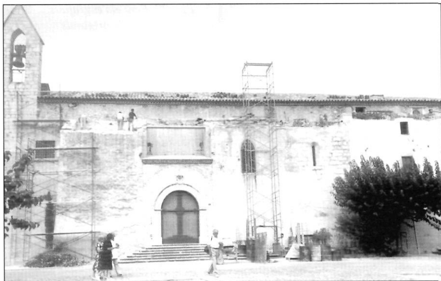
Fig. 27. Enderrocament de la zona afegida damunt de les capelles i de la casa del capellà (agost de 1988)
