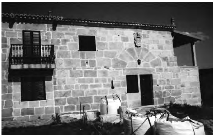
Fig. 5. A mesma casa restaurada recentemente
