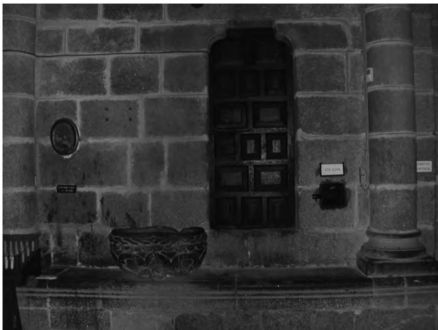
16.-Puerta de subida al tejado de la catedral, cercana a la entrada sur
