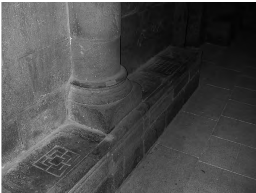
5.- Otro aspecto de la bancada (número 2) del muro de sur
