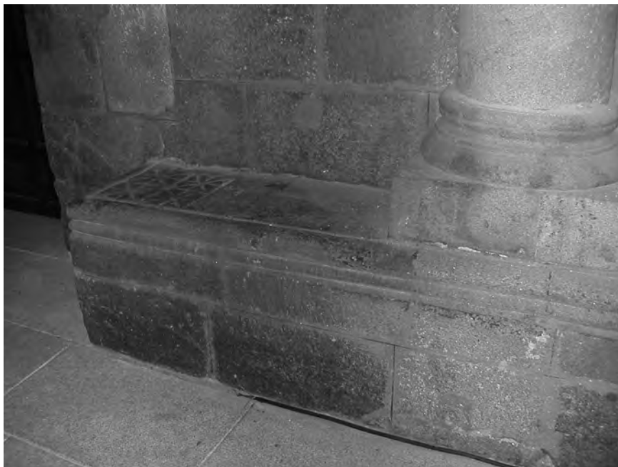
3.-Aspecto de la bancada (número 1) del muro sur de la catedral de Ourense
