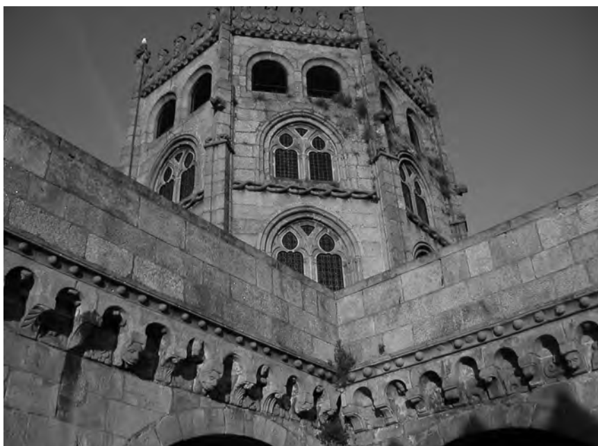
2.-Vista parcial del cimborrio de la catedral de Ourense
