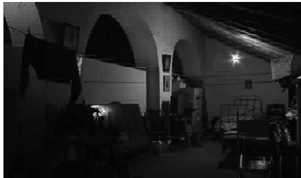
FIG. 8. SOBERAOS: ALIGERAMIENTO DEL MURO. VERSATILIDAD.
