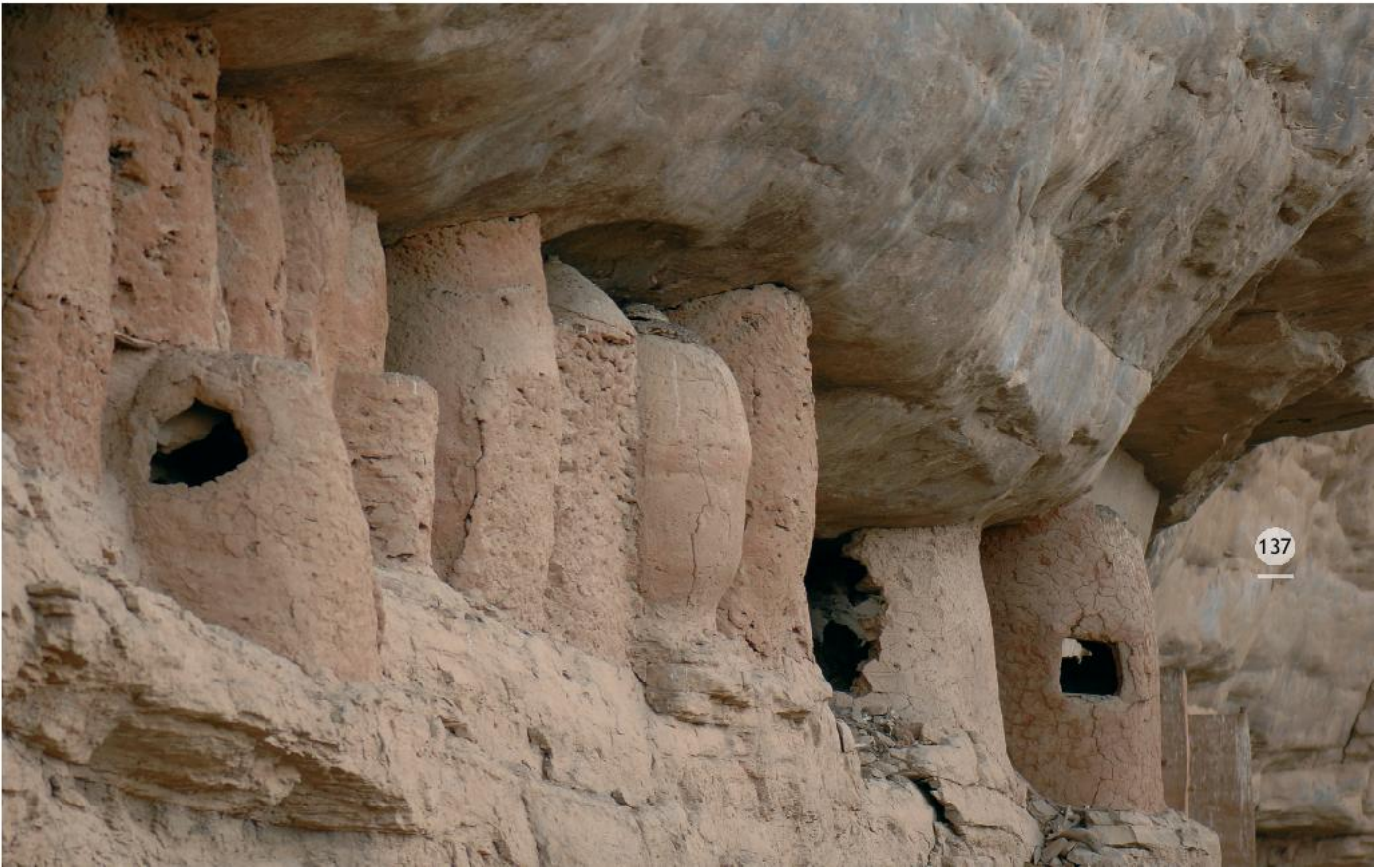
Enterramientos Tellem en grietas de difícil accesibilidad.
