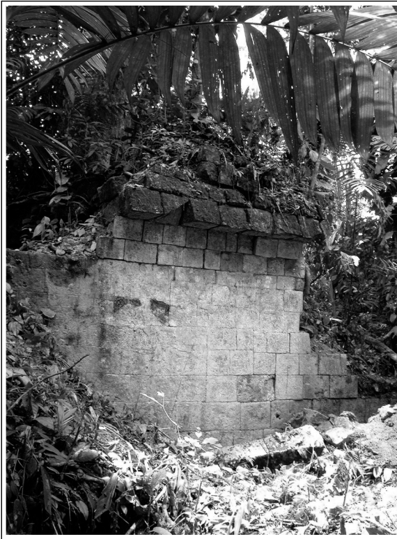
Figura 3. Machaquilá, Estructura 32: mampostería de revestimiento en la transición del Clásico Tardío al Clásico Terminal.
