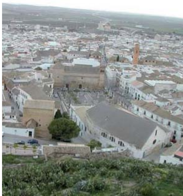
VISTA DE LAS CUBIERTAS DESDE LA IGLESIA COLEGIAL.
