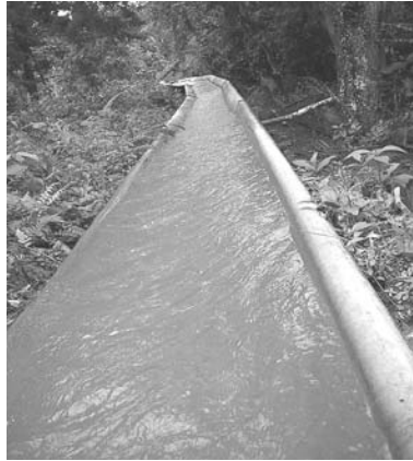
Figura 12 Canaleta de prueba
