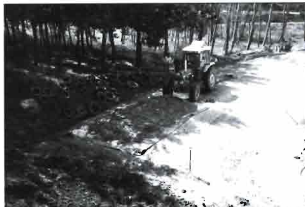
Forraje compactado antes de ser recubierto.
