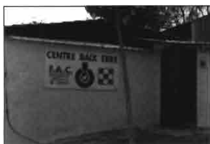
Vista exterior del Centro de I.A., que actualmente dispone de 200 machos.
