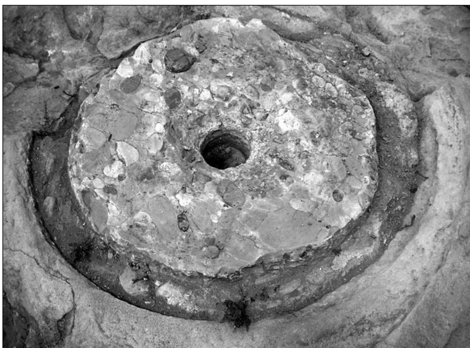
Figura 5. Detalle. Pieza encofrada añadida para nivelar la solera del molino
