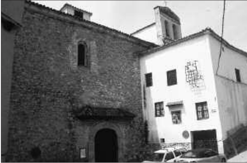
Pastrana. Convento de San José. Portada de entrada a la iglesia, fachada del convento y espadaña.
