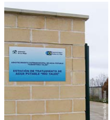
La potabilizadora de Santa Coloma abastece 12 municipios.
