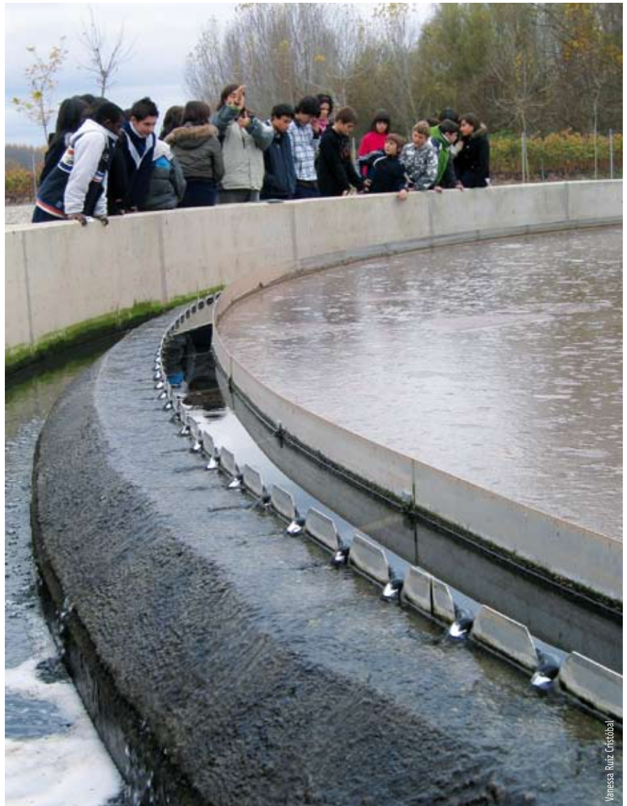
La visita a la depuradora ayuda a que los jóvenes entiendan el proceso de limpieza del agua residual.
