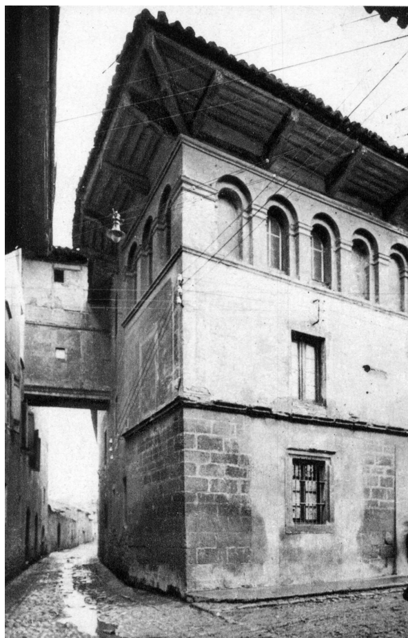
Casa-palacio de Añés que estaba adosada a la iglesia.
