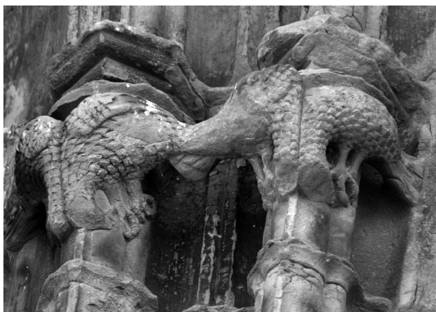
Detalle de la ventana del tramo pies
