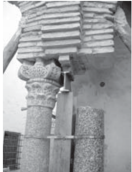
Sustitución de los capiteles del Callejón de la Reja
