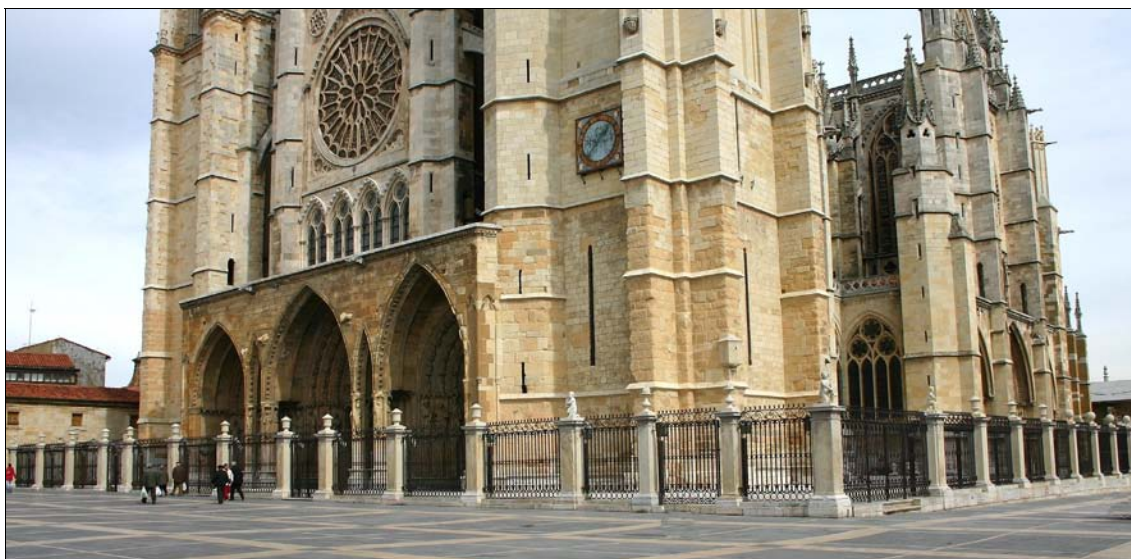
■ Lám. 1. Vista actual del atrio de la catedral (foto del autor).
