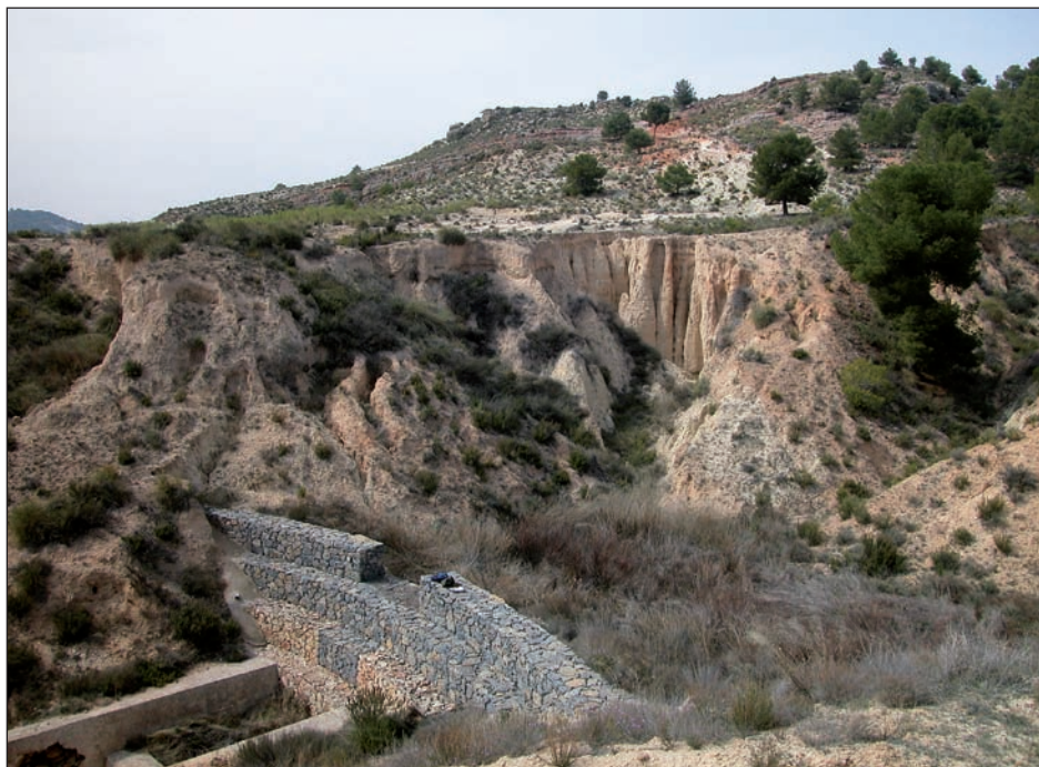
Figura 2. Dique construido en 1962, recreido en 1996 y en la actualidad funcional
