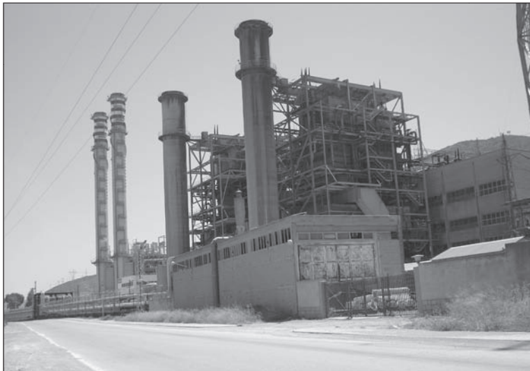
Foto 14 CENTRALES DE IBERDROLA EN ESCOMBRERAS. TÉRMICAS DE FUEÓLEO Y DE CICLO COMBINADO. JUNIO 2008
