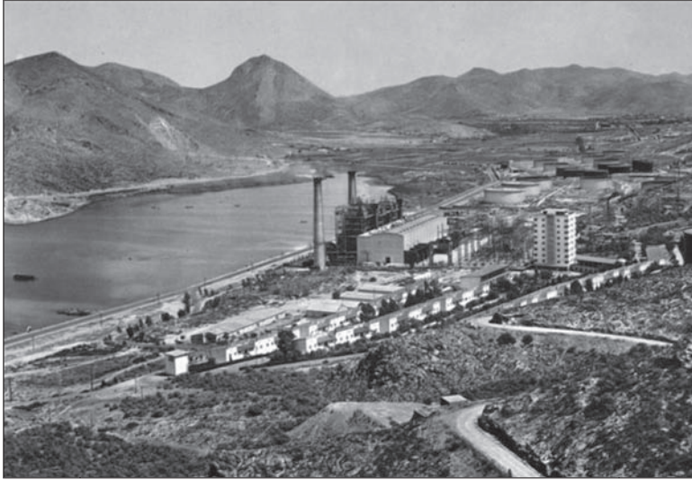
Foto 5 CENTRAL TÉRMICA DE ESCOMBRERAS. MARZO 1963
