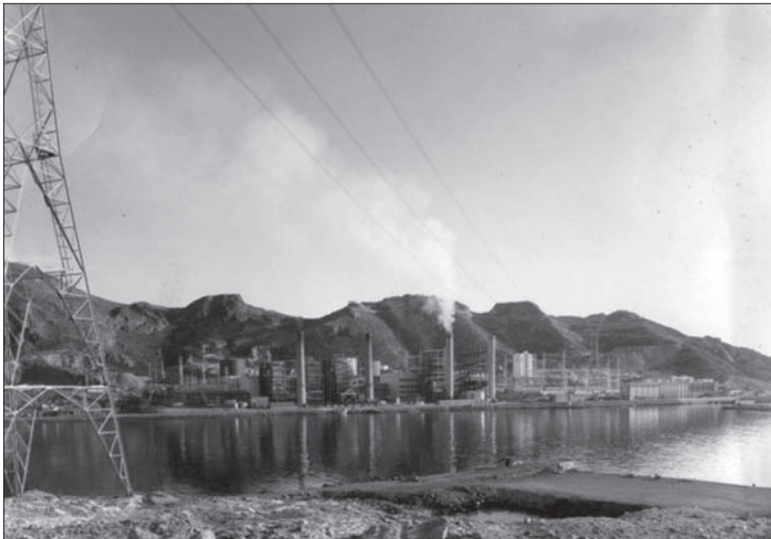
Foto 6 CENTRAL TÉRMICA DE ESCOMBRERAS. SEPTIEMBRE 1967
