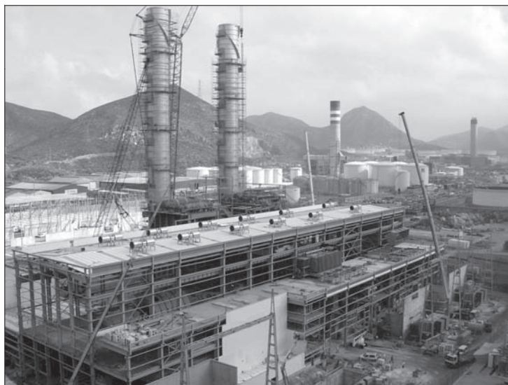
Foto 12 CENTRAL DE CICLO COMBINADO DE IBERDROLA EN CONSTRUCCIÓN. OCTUBRE 2005
