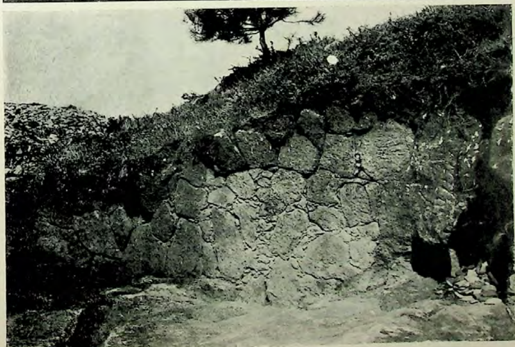
Lám. XIV.—1. Detalle de las construcciones del Grupo VIII (tomada desde f, plano parcial fig. 7. a ).—2. Aparejo del muro de contención de la calle L del Grupo VIII (tomada desde g, plano parcial fig. 7. a ).
