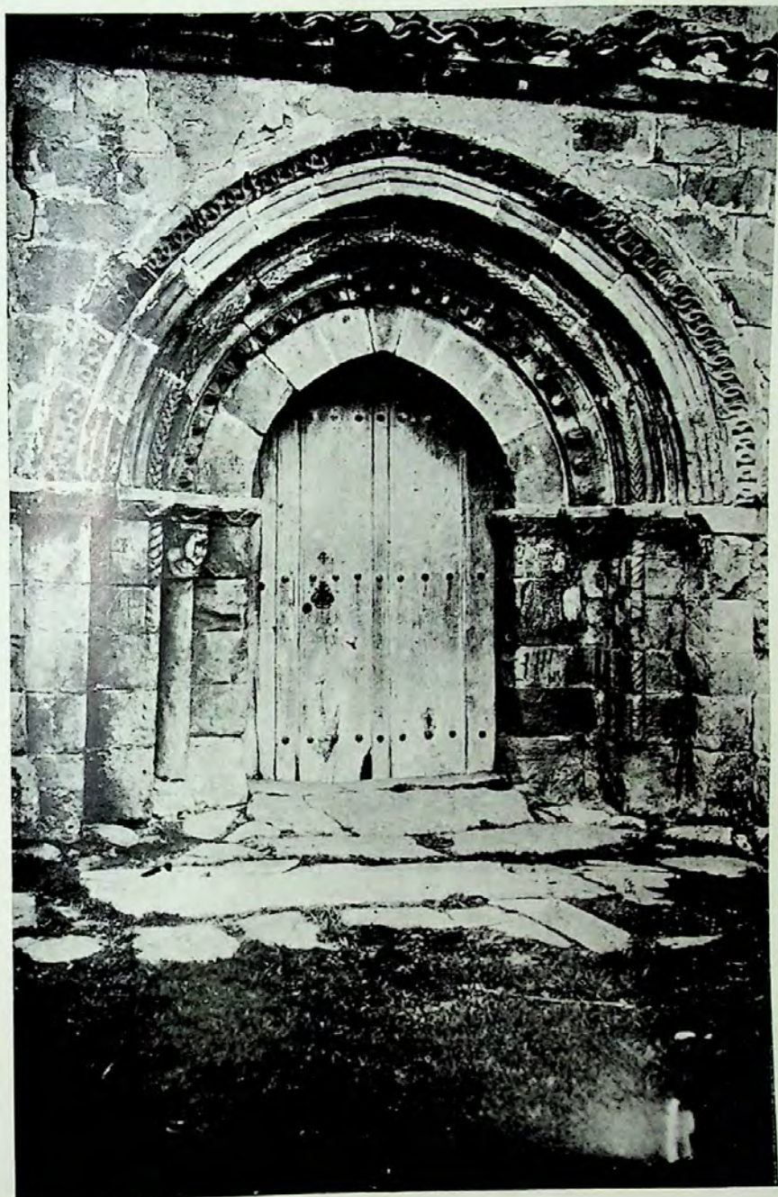
LÁMINA II.—Santa María de Villacantid. Puerta.
