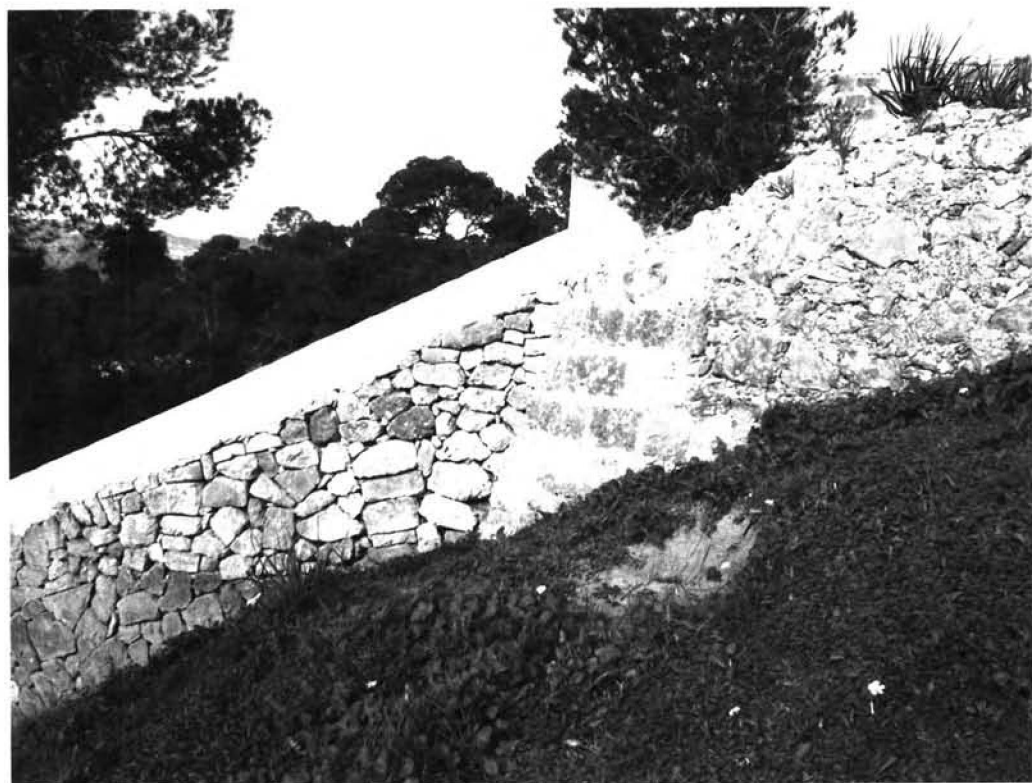
7.- Paret adossada als parapets triangulars del castell de Bellver.
