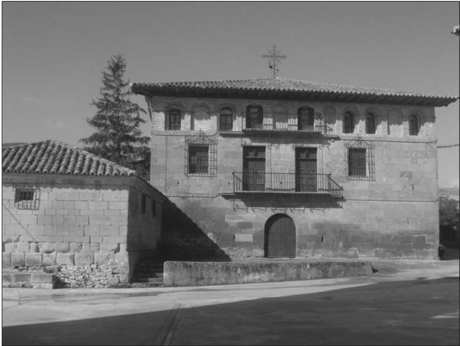
Fachada principal del Palacio de Acedo en su estado actual
