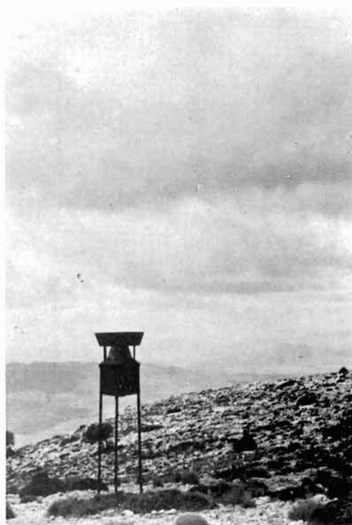
Pluviómetro instalado en el Morrón de Totana (1.580 m.)
