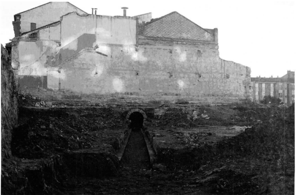
LÁM. 2. Detalle de la canalización, perdiéndose bajo la fábrica de harinas
