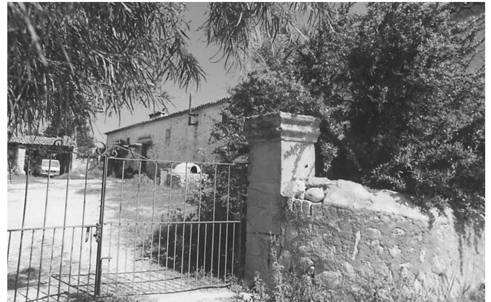
Entrada a la claustra principal de els Caüills. Alrededor de ésta se levantan los edificios que forman la possessió . A la derecha, fachada principal de la denominada casa de l'amo .
