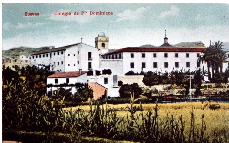
Figura 9.- Vista panorámica del colegio, apreciándose a la derecha del campanario el antiguo edificio conventual y a la izquierda del mismo el edificio de nueva planta que supuso una notable ampliación de las instalaciones educativas. Postal coloreada datada hacia 1910. (Foto de Federico de Blain Becerra / Col. Enrique F. Bolea).
