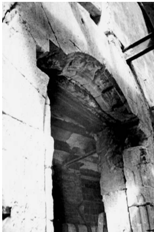
Detalls de l'arc romànic de l'hospital dels Ardèvol, tal com vàrem descobrir-lo en les obres de la nostra reforma comercial (1959). Com es veu, era tot inaprofitable.
