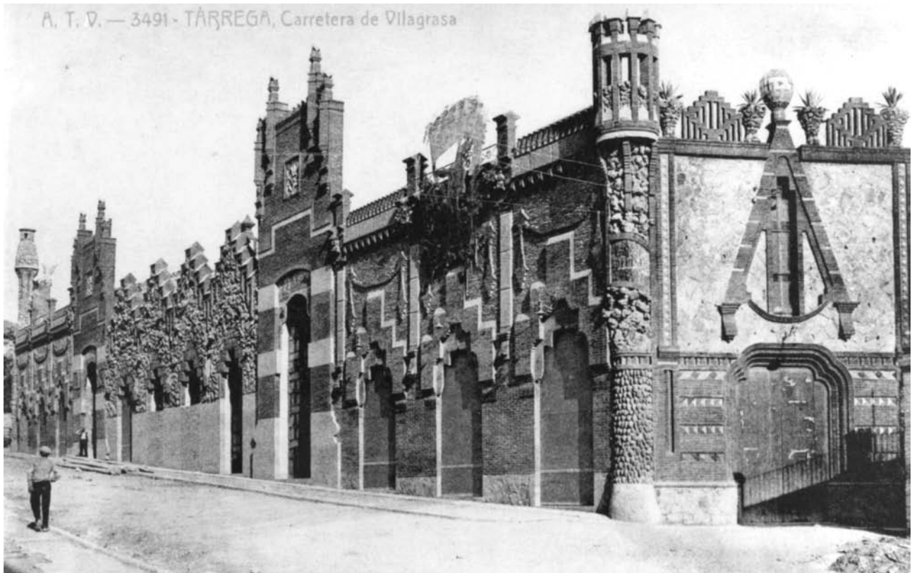
Edifici modernista construït pel Sr. Enric de Càrcer en els anys 1909 i 1910, que foren en gran part ocupats per L'Aliança.
