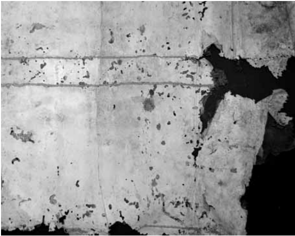
Foto núm. 9 Atac realitzat per coleòpters (corcs). En aquesta imatge, es poden apreciar els forats i les petites galeries
