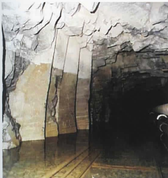
Galería que muestra el agua de repisa y los prismas de retracción del basalto.
