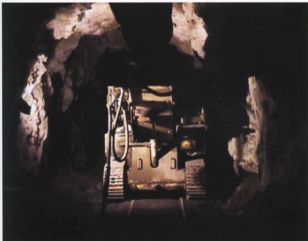
Maquinaria de perforación para la ejecución de galerías.
