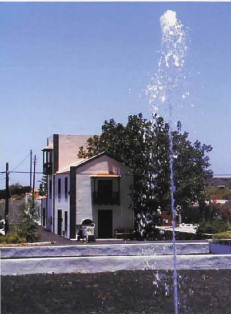
Edificio del pozo “Los Padrones” (valle de El Golfo, El Hierro), mostrando la salida de agua por gravedad, lo que le otorga el título de único “pozo artesiano” de Canarias y merecedor por ello del Premio Agustín de Bethencourt a la mejor Obra Civil.
