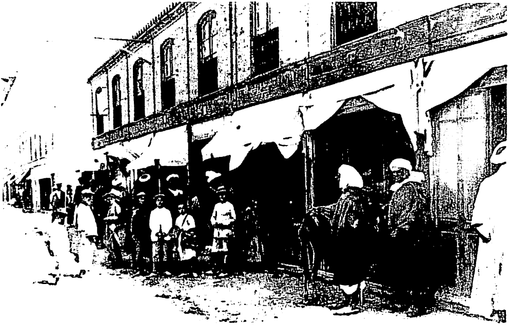
Comercios adosados al Muro X, en el Mantelete
