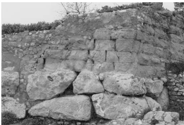
Lámina 59. Tarraco : esquina Noreste de la muralla de la ciudad, perteneciente a la segunda fase de la misma, datable en el tercer/último cuarto del siglo II a.e., concretamente entre los paseos Torroja y Sant Antoni en lo que era el baluarte moderno de Sant Josep. Obsérvese la técnica del zócalo poligonal, con bloques apenas desbastados casi en bruto que incluso podrían ser adscritos a la I manera de Lugli. El alzado se opus quadratum se encuentra muy estropeado en este punto.
