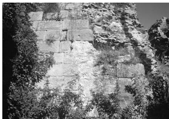
Lámina 26. Gerunda: Torre Gironella. Vista general de la cara occidental de la misma, en la que se aprecia la fábrica de sillares de opus quadratum del crecimiento de los muros, presuntamente del siglo III, y el relleno interno de opus caementicium que se depositó en su cámara hueca interior, para lo cual hubo de ser tabicada la puerta que se aprecia en el centro de la imagen. La cronología del basamento de esta se localiza en el segundo cuarto del siglo I a.e.
