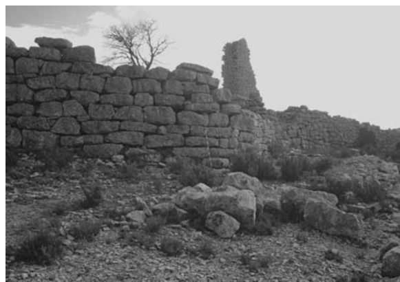
Lámina 43. San Pedro de Oliete: muralla exterior de aparejo poligonal ibérico que se asemeja al romano de la II manera de Lugli incluso en la presencia de cuñas triangulares de calzadura. La cronología de esta obra se localiza a finales del siglo III a.e.
