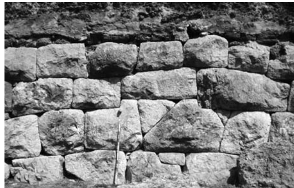
Lámina 8. Emporiae (Ampurias romana): muralla meridional, con zócalo de opus quadratum de la IV manera y crecimiento de opus caementicium . Obsérvese en el basamento de piedra los bloques que tienden a formar cuatro hiladas, el almohadillado rústico sin listel perimetral en este caso, así como las cuñas triangulares y trapezoidales de calzadura. La cronología de esta obra, no del todo clara, tiende a localizarse a principios del siglo I a.e.
