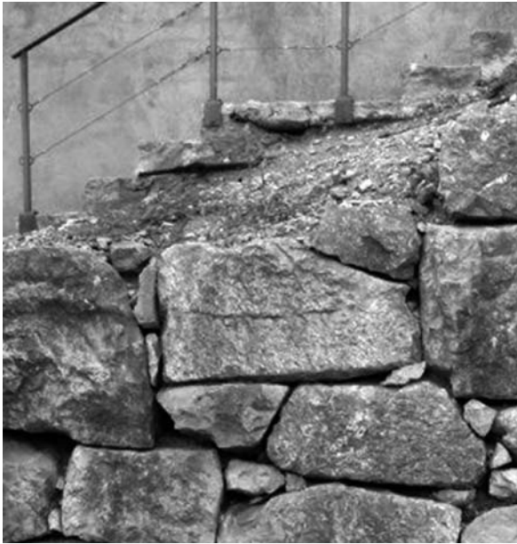
Lámina 15. Emporiae (Ampurias romana): sector Norte de la muralla oriental. Aparejo de opus siliceum que puede ser adscrito a la II manera, con bloques irregulares reuntados con cuñas y abundante ripio. La cronología de esta obra, por criterios estratigráficos, se localiza a principios del siglo I a.e.
