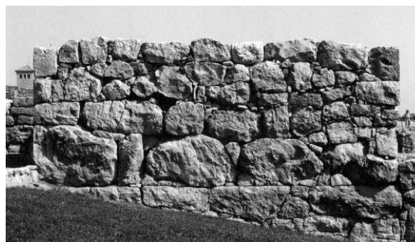
Lámina 20. Emporiae ("Neápolis" de Emporion ): torre oriental de la puerta de la muralla Sur de la ciudad. Aparejo monumental de opus siliceum cercano a la II manera de Lugli en el que destaca la parte inferior, que dibuja una especie de lecho completamente horizontal del que parte el crecimiento en altura. La cronología de esta obra se localiza a mediados del siglo II a.e.
