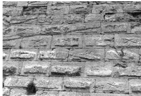
Lámina 62. Tarraco : detalle del aparejo de opus quadratum del alzado en talud de la segunda fase de la muralla de la ciudad, datable en el tercer/último cuarto del siglo II a.e., en concreto en la Bajada del Roser. Obsérvese la gran regularidad de los sillares, con almohadillado alisado, con notable relieve, enmarcado con listel perimetral de gran anchura, la presencia de algunos engatillamientos y sobre todo de numerosos signos incisos en la cara externa de algunos bloques.
