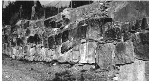
Lámina 1. Aeso: muralla del sector denominado "La Torreta", datada a finales del siglo II o comienzos del I a.e. Obsérvese su aparejo poligonal cercano a la II manera de Lugli asentado en seco con ripio y cuñas de calzadura (rejuntado con mortero en a restauración de los años noventa del siglo XX).
