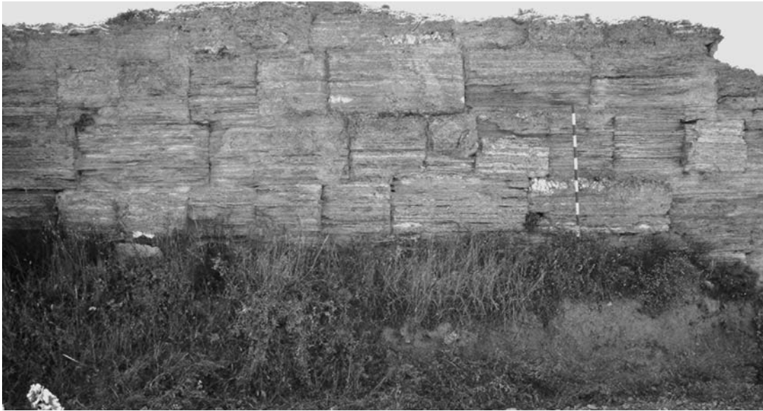
Lámina 44. Segeda II : muralla Norte de opus quadratum con sillares, tallados sobre yeso alabastrino local, colocados a soga y tizón sin un orden aparente. La cronología de esta obra podría situarse en el último cuarto del siglo II a.e.
