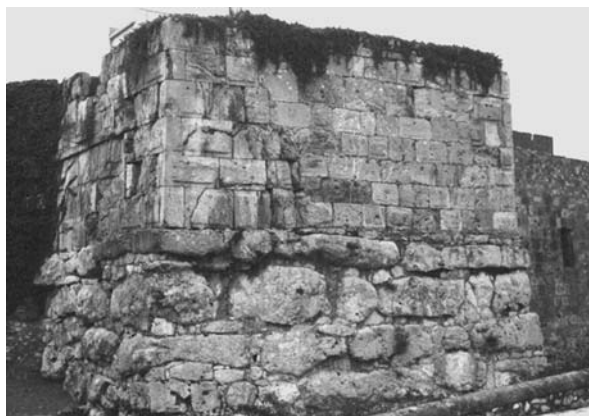
Lámina 55. Tarraco : vista general de la Torre de Minerva/Sant Magí desde el Nordeste, perteneciente a la primera fase de la muralla de la ciudad, datada en torno al 200 a.e. Obsérvese el aparejo poligonal de la II manera del zócalo, de alzado troncocónico, y el aparejo de opus quadratum original del alzado, sólo conservado en la cara Este y la esquina Noreste, con bloques con la cara externa de tendencia cuadrada provistos de almohadillado alisado enmarcado por listel perimetral de notable anchura y con presencia también de orificios tallados para ser elevados por medio de ferrei forfices , tapados posteriormente con unas pequeñas plaquitas de piedra.
