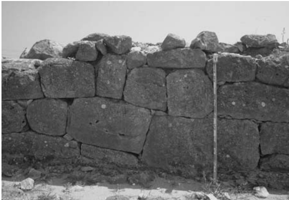
Lámina 7. Emporiae (Ampurias romana): muro intermedio Este-Oeste de separación al Norte del foro de la ciudad; cara septentrional. Obsérvese su aparejo poligonal de la II manera de módulo pequeño-medio datable a comienzos del siglo I a.e.
