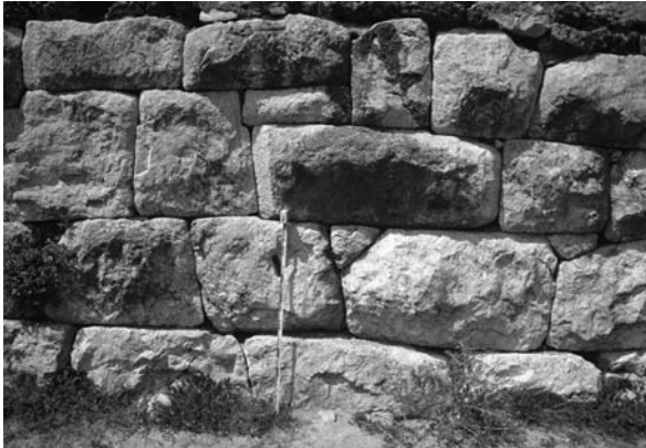
Lámina 11. Emporiae (Ampurias romana): muralla meridional. Zócalo de aparejo poligonal de la IV manera con cuñas triangulares, sillarejos de calzadura y algunos bloques provistos de almohadillado rústico e incluso listel perimetral. La cronología de esta obra tiende a localizarse a principios del siglo I a.e.
