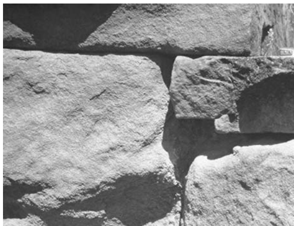
Lámina 68. La Vispesa: muro perimetral Noroeste de opus quadratum . Detalle de su extremo meridional, con sillarejos de calzadura, en el centro de la imagen, para regularizar el terreno natural y crear una superficie horizontal desde la que crecer el alzado de sillares. La cronología de esta obra puede situarse en la primera mitad o mediados del siglo I a.e.
