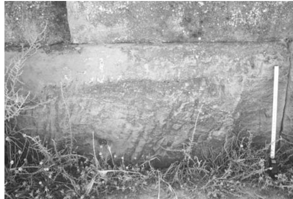
Lámina 71. La Vispesa: detalle de uno de los sillares del muro perimetral Sudeste de opus quadratum , en el que se aprecia la terminación de los mismos, con almohadillado alisado a puntero, listel perimetral bastante amplio (unos 10 cm) en el que se esgrafió un signo silábico ibérico ka (justo bajo el metro). La cronología de esta obra puede situarse en la primera mitad o mediados del siglo I a.e.
