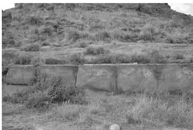
Lámina 23. Gabarda: gran muro Este-Oeste de opus quadratum del sector Sudeste del yacimiento. Obsérvese cómo la parte inferior de los sillares fue tallada para adaptarse al declive del sustrato natural rocoso. La cronología de esta obra podría localizarse en la primera mitad del siglo I a.e.
