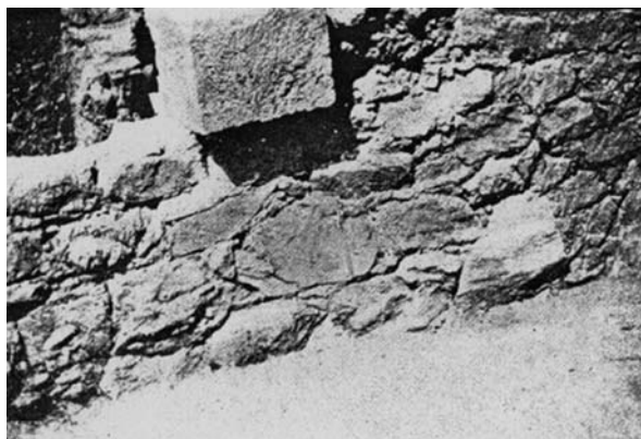
Lámina 2. Baetulo : aparejo de la muralla descubierta en los años treinta del siglo XX, poligonal de módulo pequeño/mediano (GUITART, J.: 1976).
