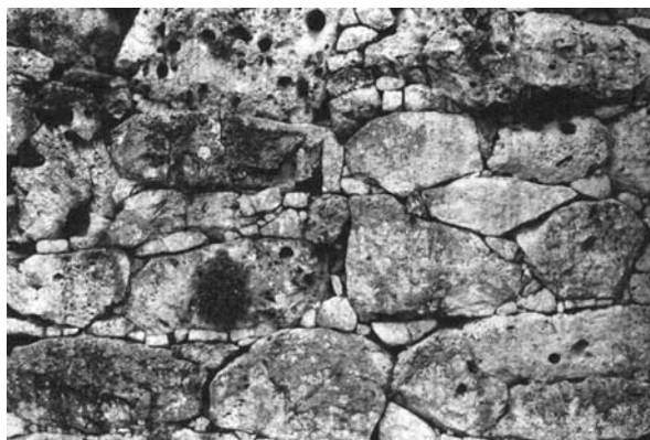
Lámina 51. Tarraco : detalle del aparejo poligonal de la II manera de las cortinas de la primera fase de la muralla, pertenecientes a un castellum datado en torno al 200 a.e. Obsérvese la irregularidad de los bloques, cuidadosamente asentados sin embargo con abundantes ripios y cuñas.
