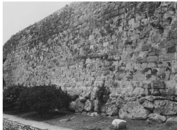
Lámina 58. Tarraco : vista general del tramo de muralla del Paseo Torroja de Tarragona, perteneciente a la segunda fase de la misma, datable en el tercer/último cuarto del siglo II a.e. Obsérvese el basamento, de altura muy escasa, poligonal de la II manera con bloques muy desiguales, y el alzado en talud de opus quadratum muy regular a soga con bloques almohadillados con listel perimetral.
