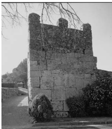
Lámina 34. Olèrdola: muralla Norte de la fortaleza; detalle del aparejo de la "Torre III", con buena parte de su fábrica romana original, en opus quadratum de la IV manera, muy parecido al de las torres de la muralla de Cosa, y parte superior medieval de mampostería. La cronología de la obra romana se localiza entre finales del siglo II y comienzos del I a.e.
