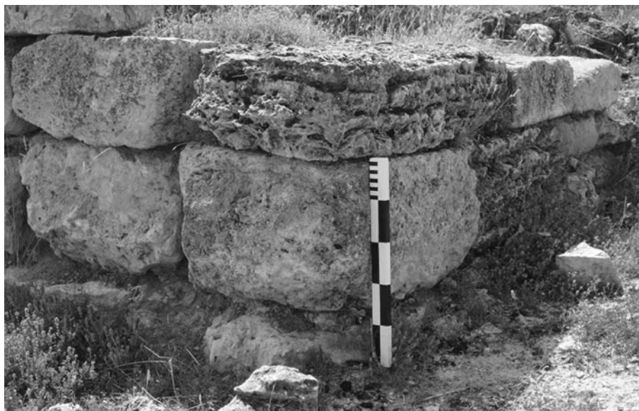
Lámina 21. Fosos de Bayona: detalle del basamento de la muralla de la ciudad, de aparejo poligonal cercano a la II manera de Lugli con esquinales provistos de almohadillado rústico y listel perimetral de notable enchura.
