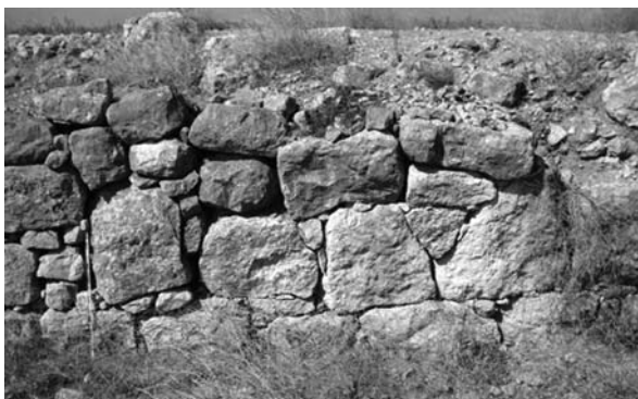
Lámina 13. Emporiae (Ampurias romana) tramo Sur de la muralla oriental de la ciudad, denominada "muralla Robert", de aparejo poligonal de la II manera. La cronología de esta obra, por criterios estratigráficos, se localiza a principios del siglo I a.e.
