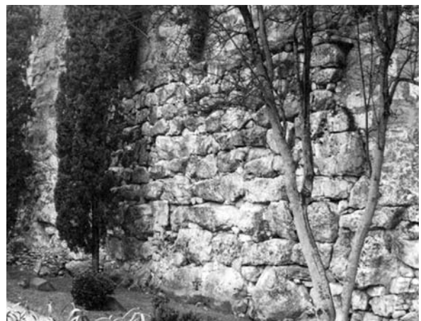
Lámina 50. Tarraco : vista general del paramento externo del tramo de muralla al Oeste de la Torre de Minerva, perteneciente a la primera fase de la misma, datable en torno al 200 a.e. Obsérvese el aparejo poligonal de la II manera con bloques muy irregulares asentados en seco con abundantes cuñas.
