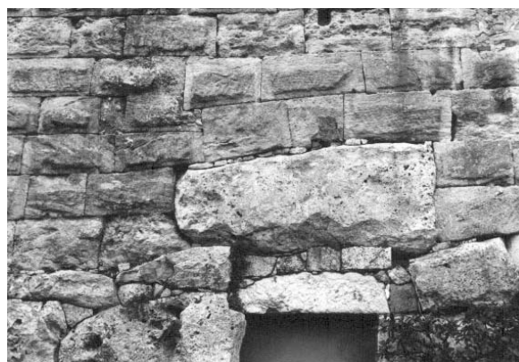
Lámina 65. Tarraco : poterna localizada junto a la Torre del Arquebisbe y perteneciente a la segunda fase de la muralla de la ciudad, datable en el tercer/último cuarto del siglo II a.e. Obsérvese la presencia de un gran dintel poligonal monolítico de descarga, sobre otro de menos tamaño, y sobre todo el aparejo de opus quadratum que rodea y se adapta al primero por medio de cuñas y bloques con llagas oblicuas que se asemejan a los poligonales de la IV manera.
