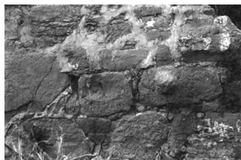
Lámina 39. Saguntum : muralla de la acrópolis del Castell, datada a principios del siglo II a.e. Detalle del muro Norte de la denominada "Torre de la Plaza de Estudiantes", de aparejo poligonal de la II manera. Obsérvese que los bloques, en uno de los cuales se talló un umbo en relieve, presentan formas irregulares y se rejuntaron con ripio y cuñas triangulares de calzadura.
