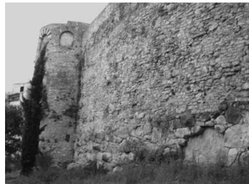
Lámina 29. Gerunda : vista general de uno de los tramos de la muralla de Les Àligues, en el sector Sudeste de la ciudad romana, con su zócalo original de aparejo poligonal de la II manera bajo un crecimiento medieval de mampostería. La cronología del zócalo se localiza en el segundo cuarto del siglo I a.e.
