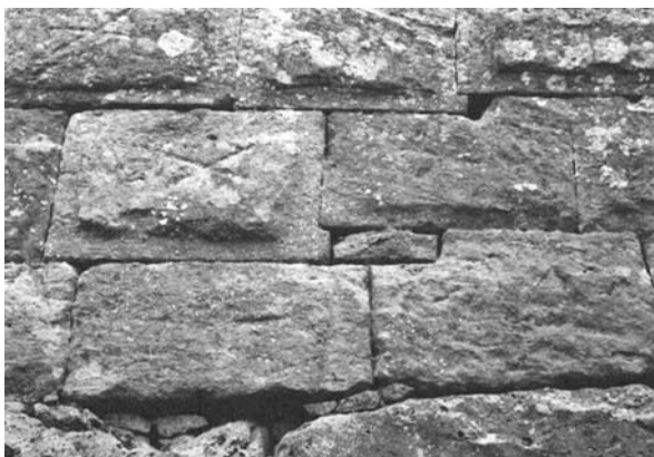
Lámina 63. Tarraco : detalle del aparejo de opus quadratum del alzado de la segunda fase de la muralla de la ciudad, datable en el tercer/último cuarto del siglo II a.e. Obsérvese la presencia de engatillamientos, de un sillarejo de calzadura y de signos incisos en la cara de algunos bloques.
