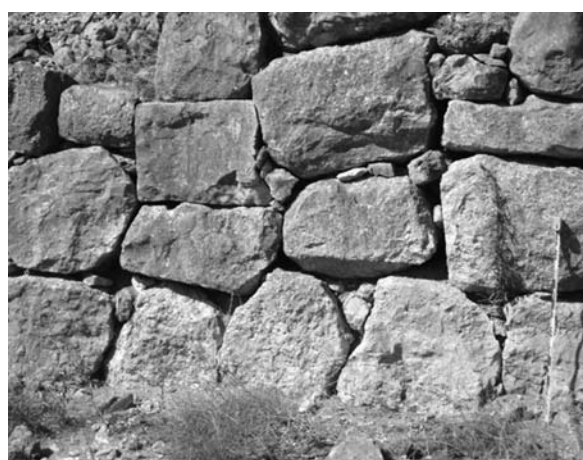
Lámina 14. Emporiae (Ampurias romana): tramo meridional de la muralla Este denominado "muralla Robert". Detalle del aparejo poligonal de la II manera, con bloque de talla irregular asentados con abundantes cuñas relleno los intersticios entre los bloques. La cronología de esta obra, por criterios estratigráficos, se localiza a principios del siglo I a.e.
