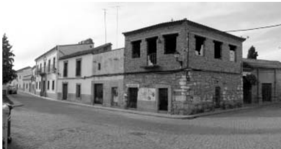
Plaza de Jesús. A la derecha del Ayuntamiento (separado por línea roja) se encuentran los solares destinados a la ampliación del museo
