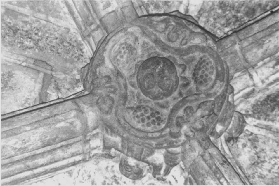
Fig. 25. Santa Maria do Azougue. Ábside sur, clave de bóveda.
