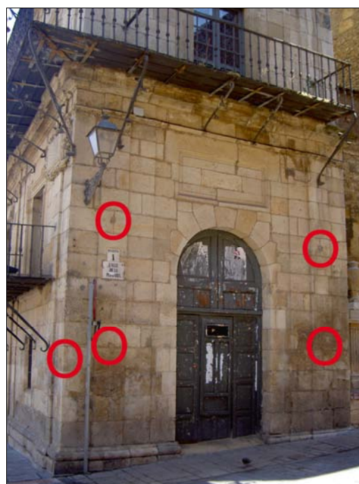
■ Lám. 10. Foto del costado del Mirador en la calle Plegaria con la puerta del Peso bajo la cartela y los huecos del sistema de anclaje del balcón.
